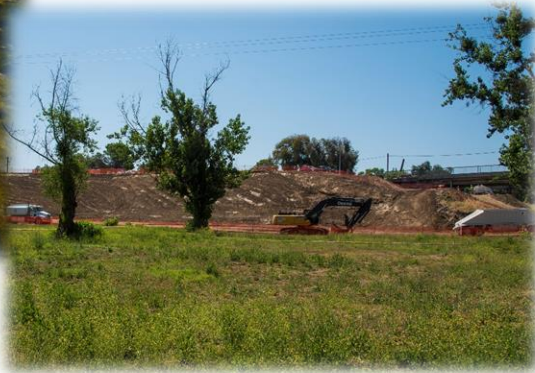
Marysville Ring Levee
